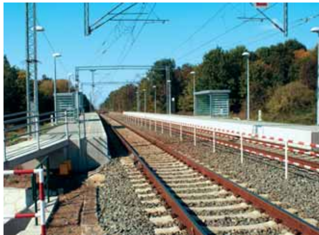
Obnovljena željeznička pruga kod Đeletovaca
