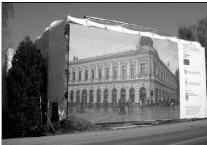
Slika 18 — Grand hotel/Radnički dom, obnova pročelja
